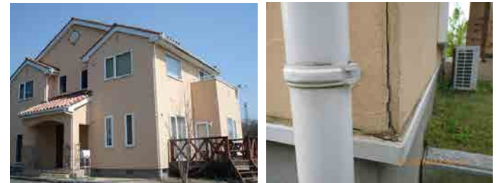
築約5年の塗り壁住宅が東日本大震災の影響で外壁に亀裂が多数発生(北茨城/震度6強)
