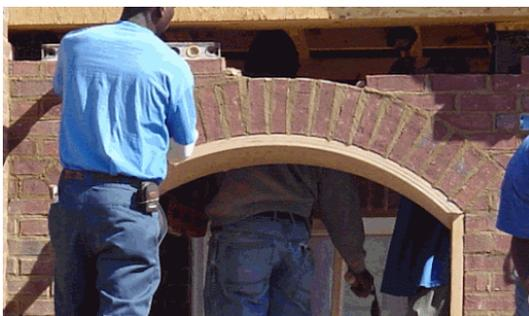
4. レンガを積み上げたら、余計なモルタルを取り除き、表面を整えます。
